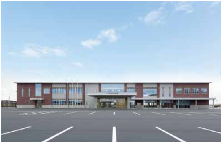
中泊町役場庁舎 青森県中泊町 / S 造 - 4,239 m 2
