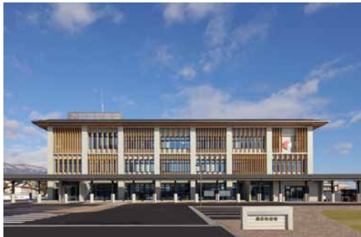
桑折町役場庁舎 福島県桑折町 / RC 造 - 4,468 m 2
