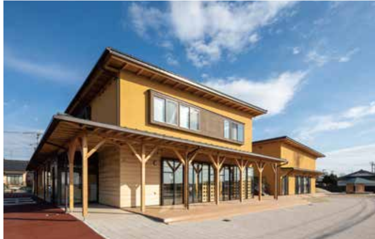
岩沼市西部地区防災コミュニティセンター 宮城県岩沼市 / W 造 - 998 m 2
