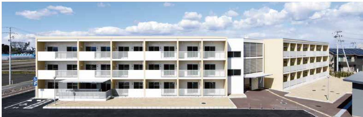
仙台市荒井南復興公営住宅 宮城県仙台市 / RC 造 - 4,240 ㎡
