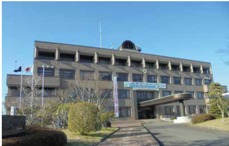
丸森町役場庁舎 (ZEB 化改修) 宮城県丸森町 / RC 造 - 5,112 ㎡
