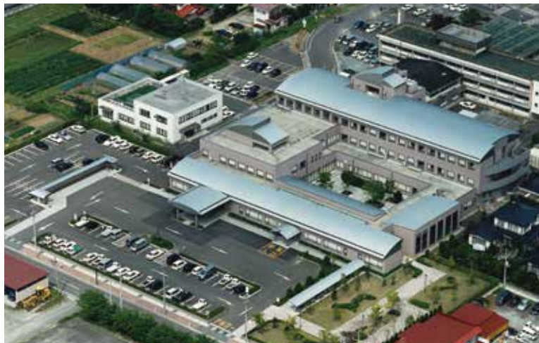
丸森病院 (ZEB 化改修) 宮城県丸森町 / RC 造 - 6,359 ㎡
