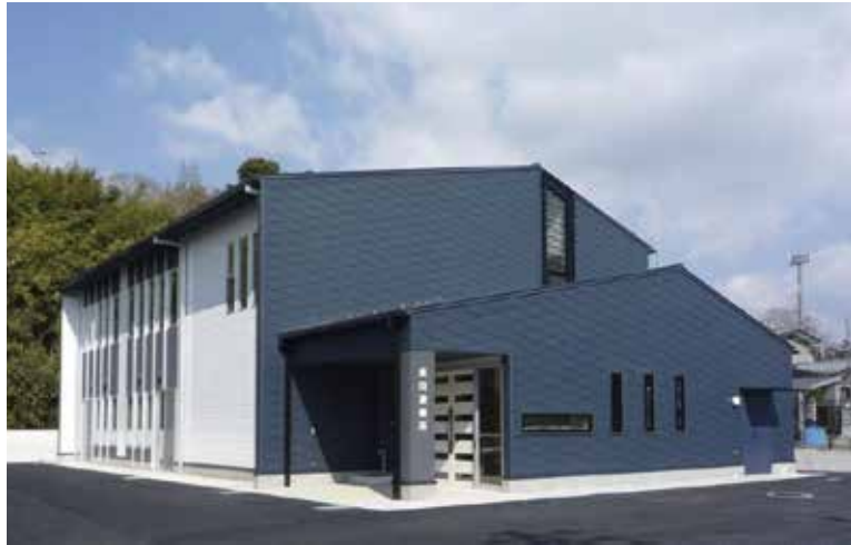
松島町長田地区避難所 宮城県松島町 / S 造 - 491 m 2
