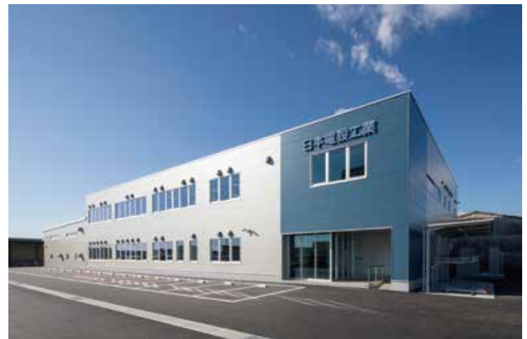
NDK 仙台東ビル 宮城県仙台市 / S 造 - 2,348 m 2
