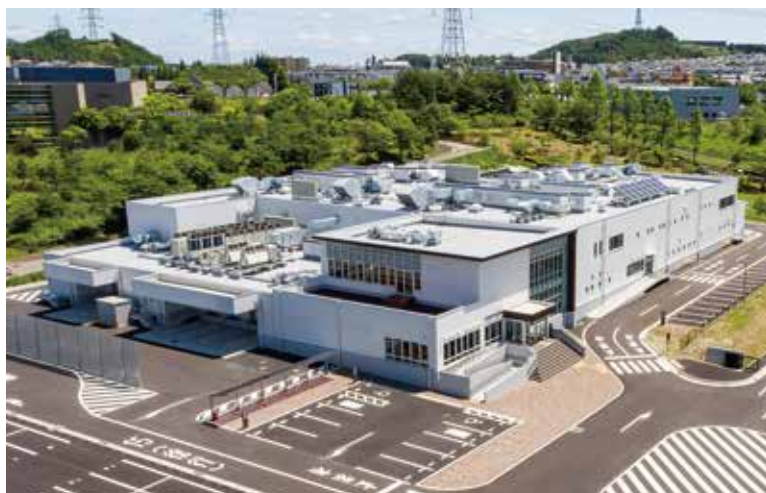
仙台市南吉成学校給食センター 宮城県仙台市 / S 造 - 6,073 ㎡
